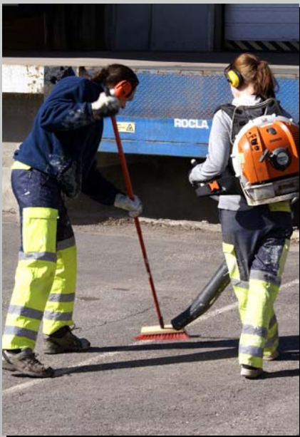
1. Puhdista huolellisesti maalattava pinta.
